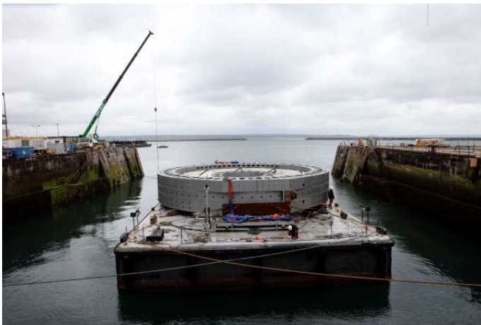
Port de Brest. Arrivée de la turbine dans la darse d'assemblage
