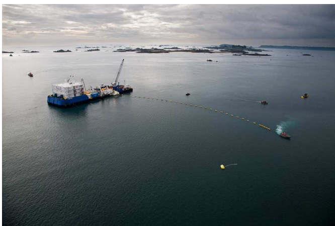
Pose du câble en Juin 2012
